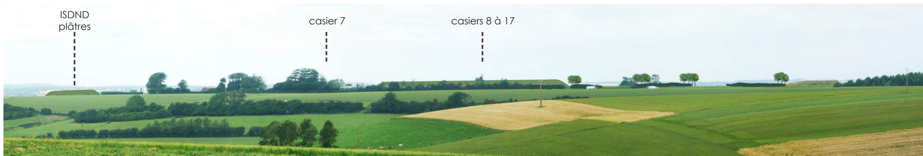
2027 : les plantations de haies et d'arbres ont été réalisées dès le démarrage de l'exploitation. Les casiers 8 à 13 sont exploités et le casier 7 a été rehaussé. La situation en 2033 est identique car les casiers 14 à 17 ne sont pas visibles depuis le sud du territoire. Seuls les arbres auront pris du volume.
